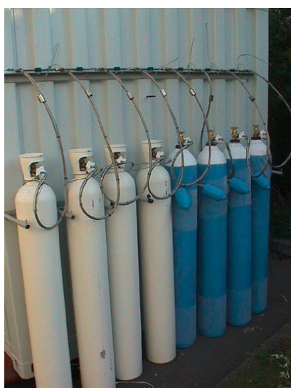
Rampe de bouteilles 50 l O2
